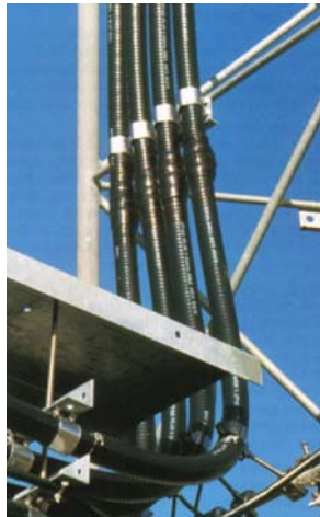
Fig. 9.26. Curvatura en líneas semiflexibles.
