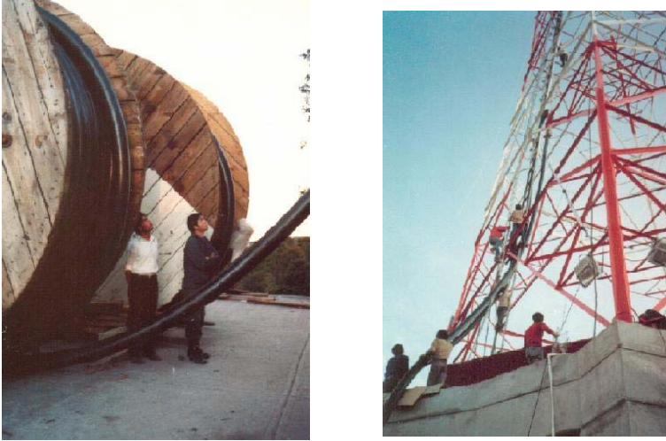
Fig. 9.24. Montaje de una línea de transmisión de 6.5".
